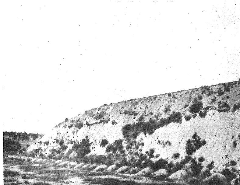
Fot. 23. — Cerro al E. de la vía del ferrocarril Madrid-Burgos, en construcción, al S. de la estación de Madrigalejo. Cima, pudingas silíceas; base, arcillas calcáreas y margas sarmatienses.
